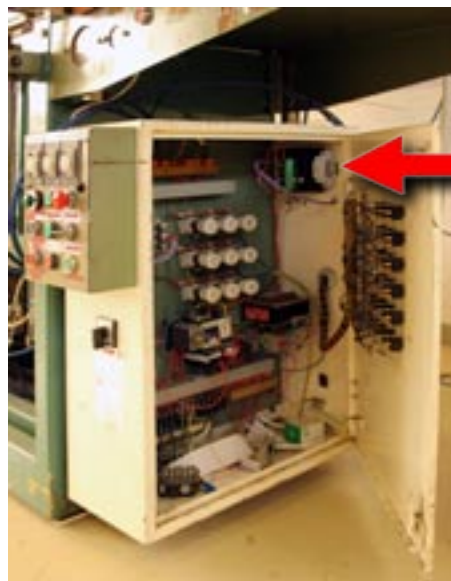
Do rozvaděče stroje se umístí jednotka DataLab, zde v provedení Compact ...
